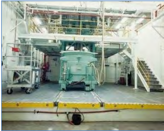
Schéma 52: Une cuve de mélange de propergol de 420 gallons. (ATK)
