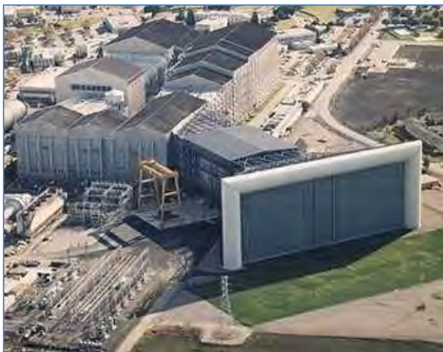
Schéma 137: Une grande soufflerie construite à l'origine pour la circulation à travers la boucle des bâtiments en arrière-plan. Le cône d'entrée au premier plan a été ajouté pour permettre également un fonctionnement à passage unique avec les mêmes ventilateurs. (NASA)
