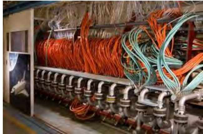
Schéma 147: Installation de chauffe à interaction (60 MW) à jet d'arc. (National Aeronautics and Space Administration (NASA))
