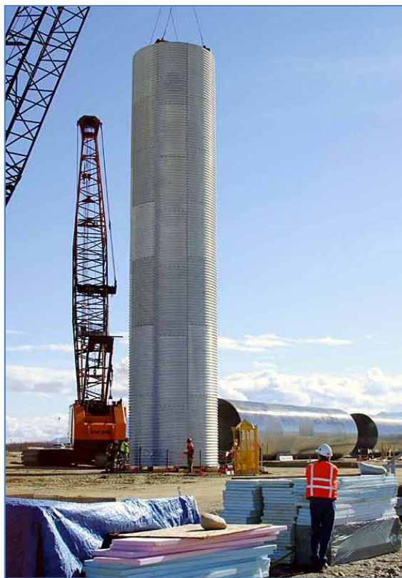
Рис. 1: Станок вертикальной шахты устанавливается в пусковой шахте ракеты при строительстве пускового комплекса. (The Boeing Company)
