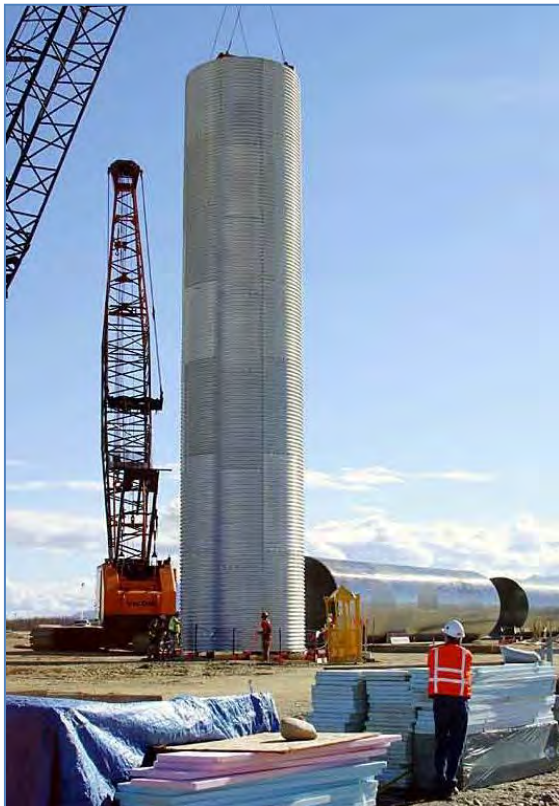
Imagen 107: Se levanta un revestimiento de silo para su instalación en un silo de misiles en un complejo de lanzamiento en construcción. (The Boeing Company)
