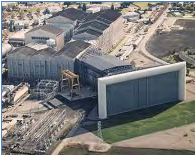
Imagen 137: Una gran instalación de túnel de viento originalmente construida para circulación a través del circuito de edificios en el fondo. Se agregó un cono de entrada en primer plano para permitir también la operación de una sola vez usando los mismos ventiladores. (JAXA)
